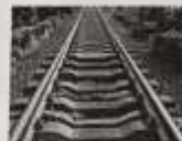
铁轨铺在枕木上
